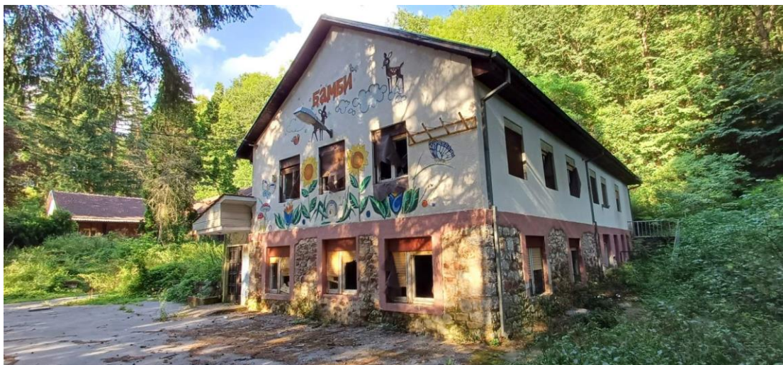
sl. 02 - Fotografija postojećeg stanja- Zgrada kuhinje i trpezarije
