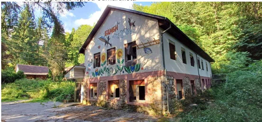
Zgrada kuhinje i trpezarije
